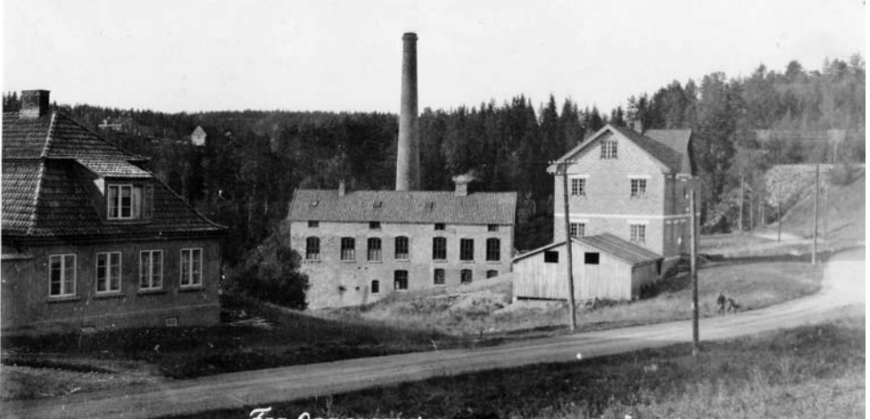
Den høye pipen er det eneste gjenværende minnet om teglverket som ble etablert på det som i dag fortsatt går under navnet Odlo-bygget (men som ikke var bygget da dette bildet ble tatt). Bygningen foran pipen var Union fargereri. Bygningen til høyre var Ansteen Hokholts trevarefabrikk, hvor bl.a. vinduene til nye Greverud skole ble produsert (brant i 1923) Helt til venstre ses en del av nåværende Greverud skole.
