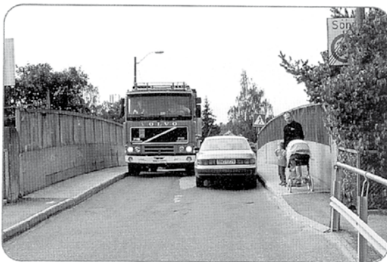
Broen over jernbanen blir ansett som et stort problem av folk i området. Først og fremst på grunn av veilbredden. Dessuten har broen en aksellastbegrensning på 7 tonn. Dette gjør at mye av den tungtrafikken som passerer er ulovlig. Problemet er bare at dette er den eneste adkomsten til området øst for jernbanen.
